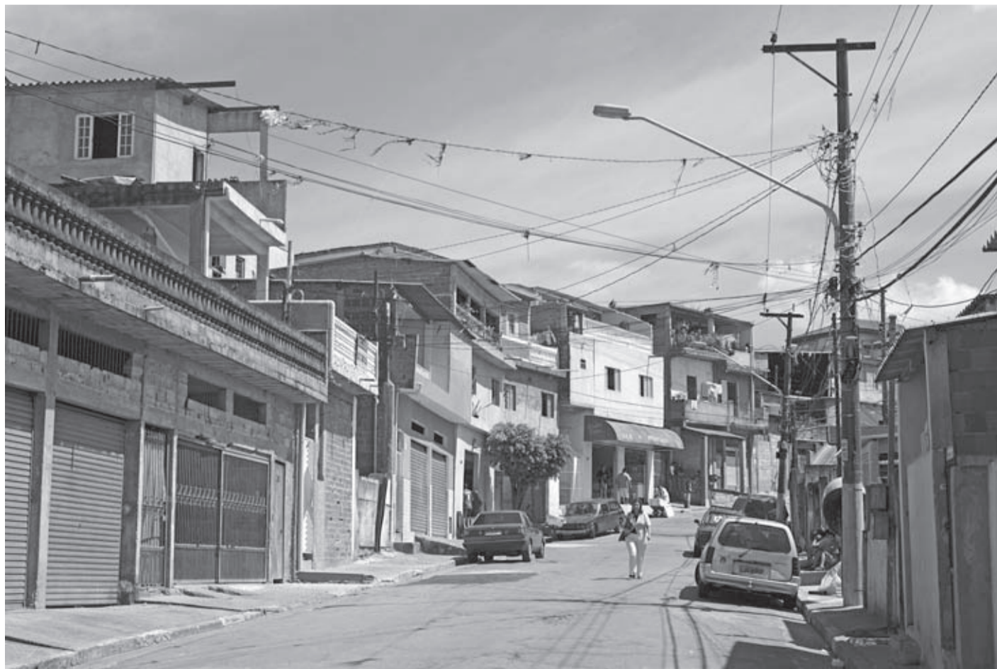
Rua principal da Vila Dalva: asfalto e casas de alvenaria, mas não há esgoto tratado e muitas ligações de água e luz são clandestinas
